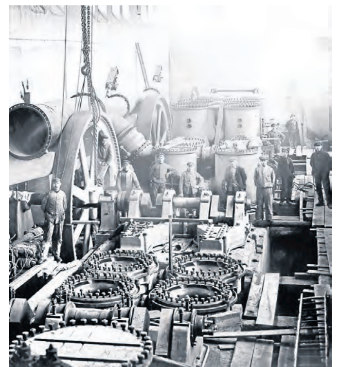
1921 war das Wasserwerk Westhofen noch eine Großbaustelle.
