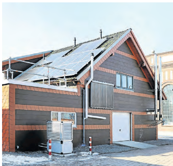
Am Energieeffizienzhaus auf der ehemaligen Zeche Hansemann trifft Industriekultur auf Innovation.
