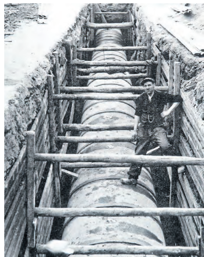
Verlegung einer Fernwärmeleitung unter Dortmunds Straßen.
