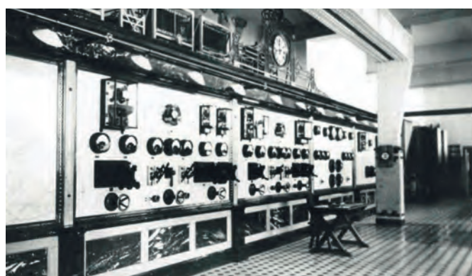
Schalter und Anzeigen, die heute niemand mehr versteht: Die Schaltwand der Motorengeneratoren.
