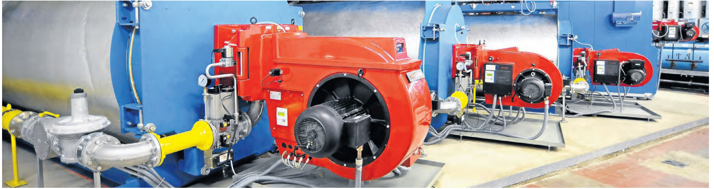
Das moderne Heizwerk in den Westfalenhallen.
