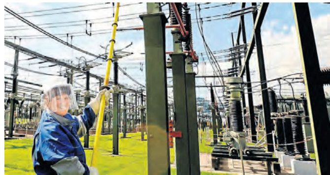
Desiree Rogge hat die Schaltberechtigung für die Mittel- und Hochspannung erhalten.
