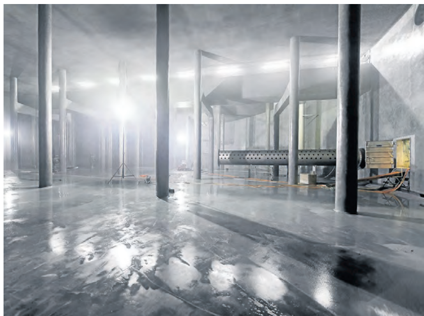
Der Hochbehälter Höchsten wurde 2014 in Betrieb genommen. FOTO HOLTHAUS
