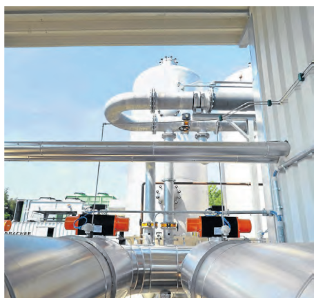
Mit Hilfe von Deponiegas werden Wärme und Strom erzeugt.
