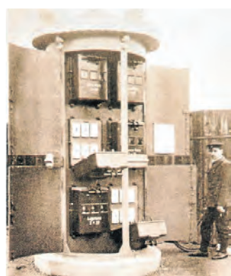
Verteilerhäuschen am Hafen, 1897
