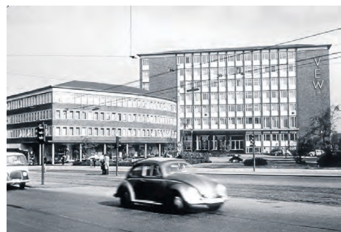
In der damaligen VEW-Zentrale am Ostwall befand sich eine Lehrküche im Souterrain.
