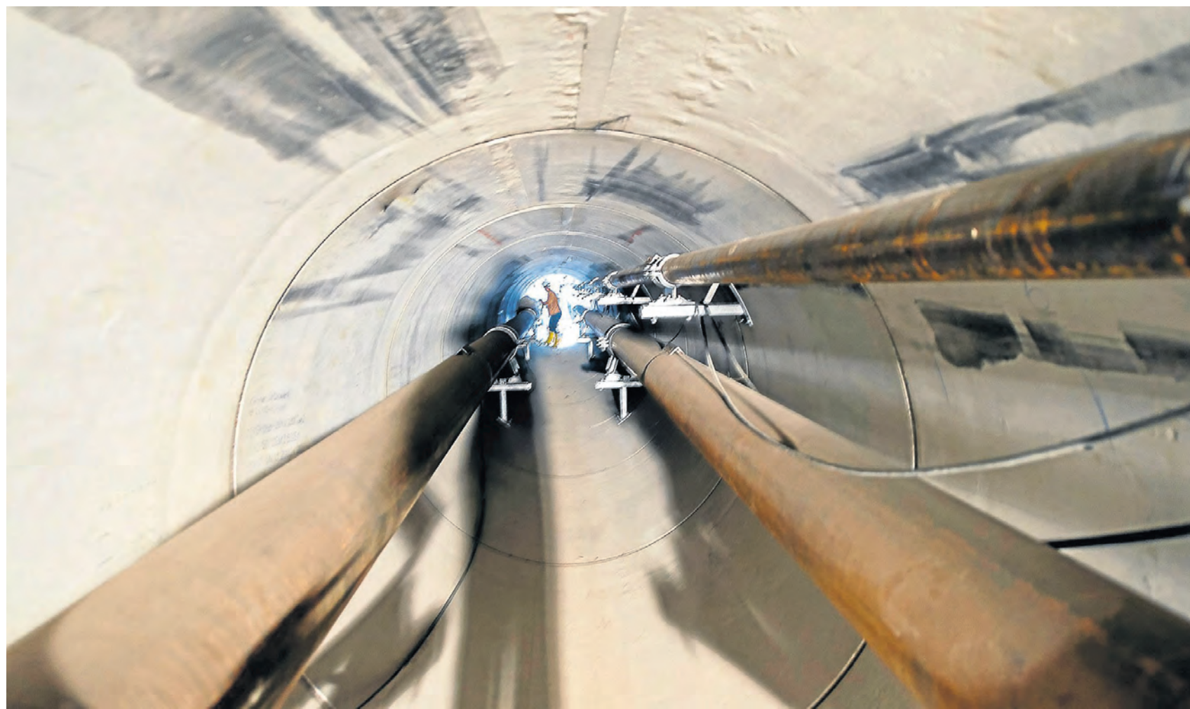
Die Erneuerung der Fernwärmeleitung unter dem Ostwall war für DEW21 eine der größten Baustellen in 2014.
