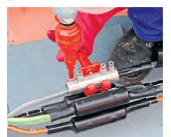
Das neue Montageverfahren im Einsatz. FOTO SCHÄFER
