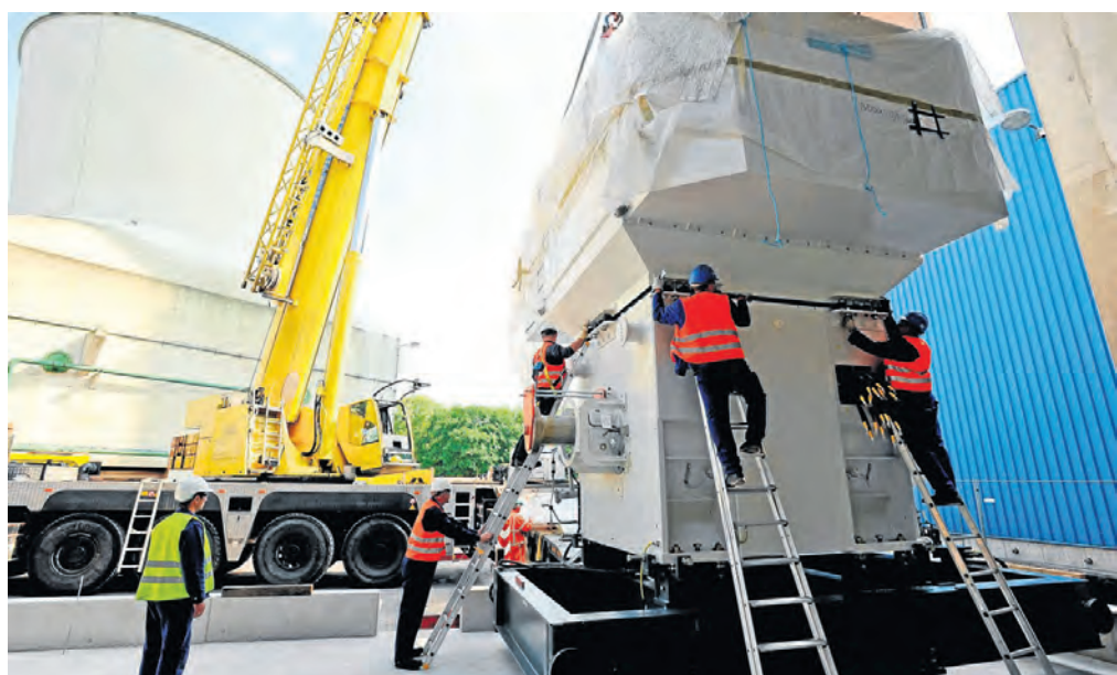
Für 14 Millionen Euro ist im Kraftwerk Dortmund eine moderne Vorschaltgasturbine eingebaut worden.
