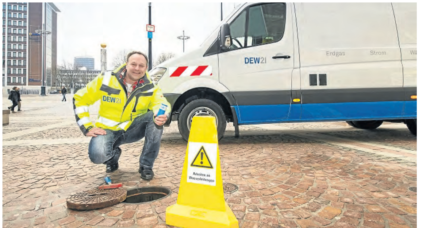
DEW21 ist „ganz Ohr“, wenn es um das Aufspüren von Lecks im Wasserrohrsystem geht.
