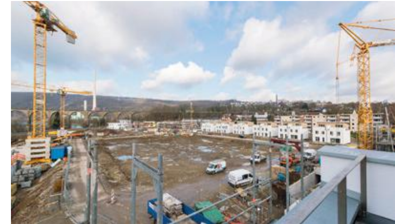
Die Bauarbeiten schreiten voran
